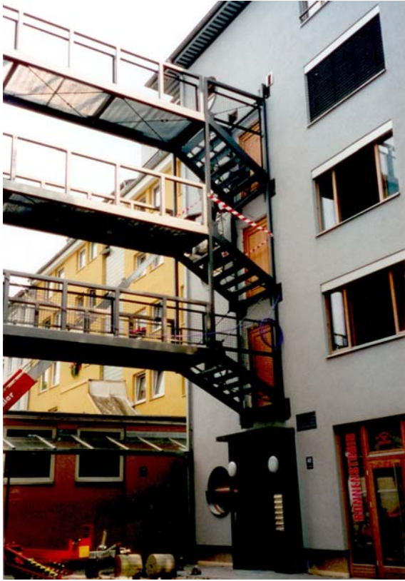
Endmontage der einzelnen Vierendelträgerstege
