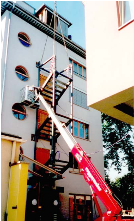
Montage des Treppen- u. Auflagerelements
