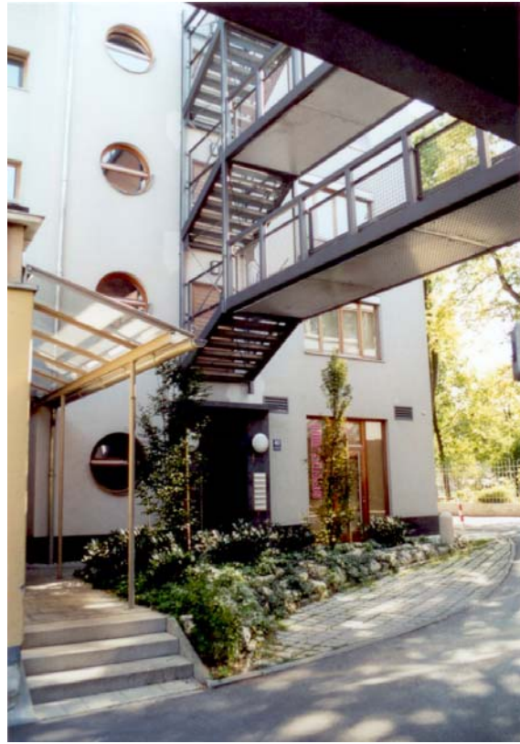
Verbindungsbrücke im fertigen Zustand
